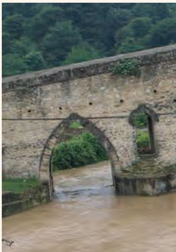
شکل ۵-۱۵ پل شیرگاه مازندران
